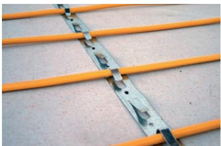
Deze methode van aanbrengen is tevens geschikt voor het aanbrengen van spuit en gietvloeren in diktes van 3 tot maximaal 6 cm.
